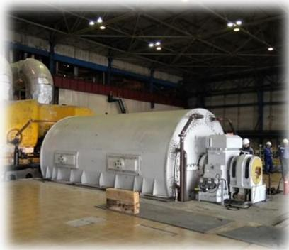
Турбогенераторы для паровых и газовых турбин на теплоэлектростанциях для производства электроэнергии
